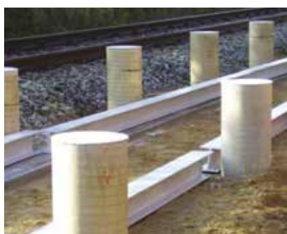
Costruzione fondazioni di calcestruzzo per la realizzazione dei punti di appoggio.
