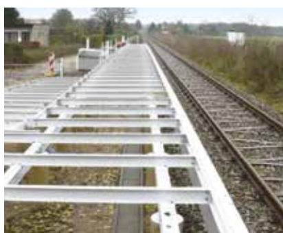
Costruzione dell'intelaiatura di travi e rinforzi in VTR.
