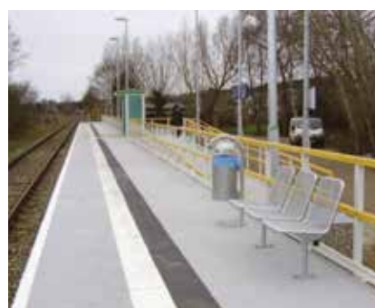
Realizzazione del piano di calpestio in grigliato a maglie o chiuso. Personalizzazione della banchina.
