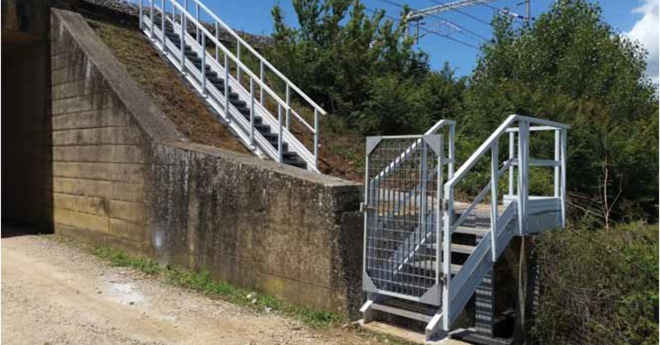
Il cancello impone l'installazione di due parapetti, in modo da ottenere una chiusura totale del varco impedendo l'accesso al rilevato, garantendo la copertura dell'intera luce libera di passaggio. Inoltre, fissando le cerniere frontalmente al montante di appoggio, si ha un'apertura totale del cancello. La posizione del cancello rispetto allo sviluppo della scala può essere scelta a piacimento.
